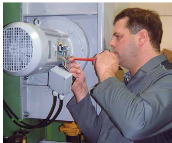
Montaż wysokowydajnej turbiny AGTOS .
