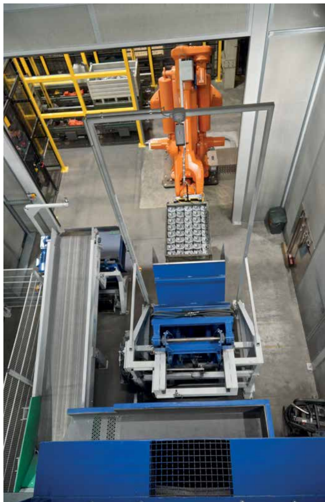
Ładunek podajnika oczyszczarki strumieniowo- ściernej z taśmą nieckową AGTOS za pomocą robota
