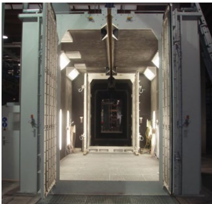
Przelotowa oczyszczarka strumieniowa z transportem podwieszonym (Konglaskilde, Kutno, Polska).
